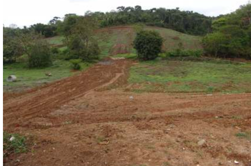
A área para a instalação da Agrovila está recebendo infraestrutura.
