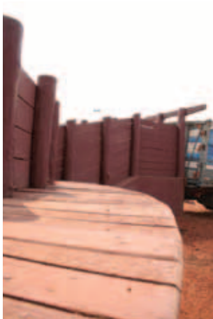
VISTA DA PASSARELA DE TRABALHO, NA LATERAL DO EMBARCADOURO
