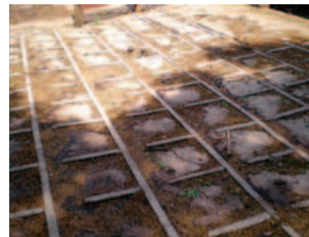
O PISO DEVE CONTER ESTRUTURAS ANTIDERRAPANTES PARA EVITAR ESCORREGÕES E QUEDAS
