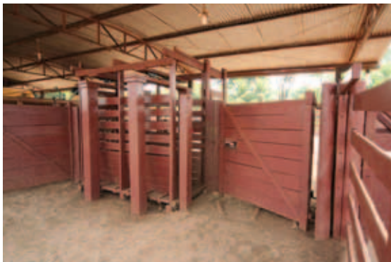
VERIFIQUE SE AS INSTALAÇÕES ESTÃO EM BOAS CONDIÇÕES
